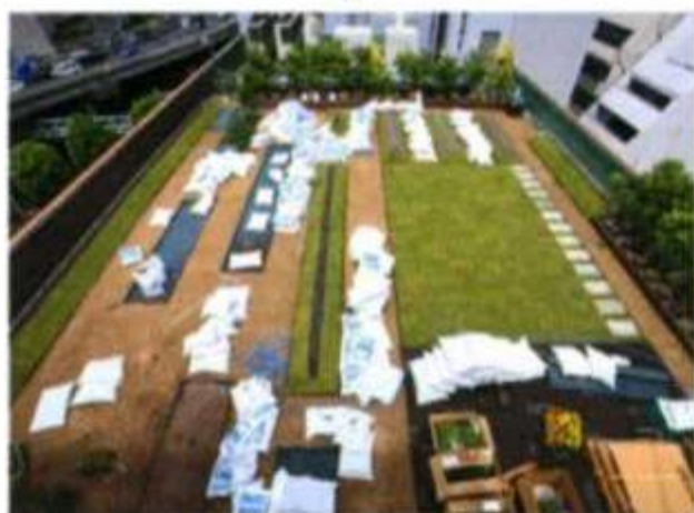
④いよいよ土入れ。歩行スペース確保のための園路工事も同時進行
