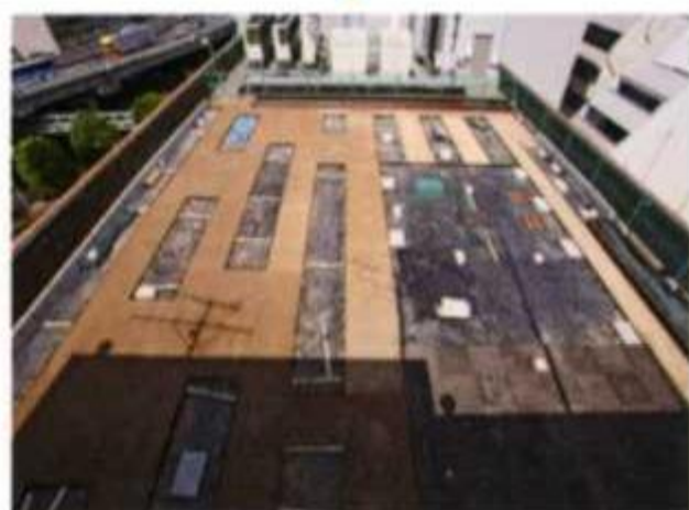
②設計図に基づき木枠を設置。屋上緑化の屋台骨が完成
