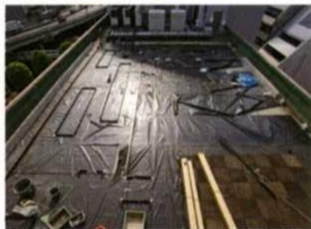
③防水層の上に耐根シートを敷設。植物の根をここでブロック
